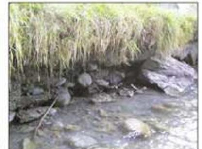
Die linke Foto zeigt beschädigte Uferverbauungen. In Bild oben wurde die Längshölzer freigelegt, während unten eine Deckschicht als Folge von Überspülungen stark zerstört ist.
